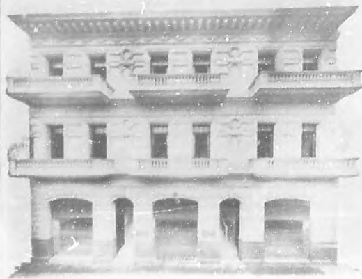
Fachada exterior de la casa Pont, Restoy y Ca. (Diseño de 1909)
